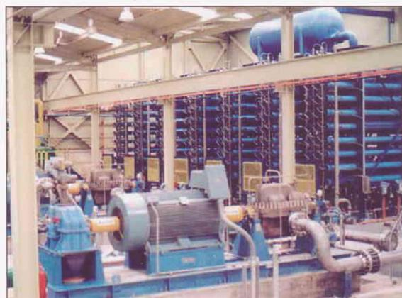
Ilustración 7: Módulos de O.I en Desaladora de Carboneras, Almería. (Fuente: Acuamed).
