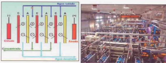
Ilustración 8-9: Descripción funcionamiento Tecnología Electrodialisis-Planta tipo EDR, Llobregat (Fuente: Aguas del LLOBREGAT).
