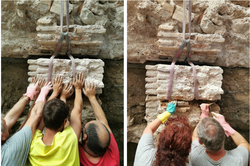
Figuras 11 y 12. Proceso de colocación de la parte superior del pilar y su posterior rejuntado. Fuente: Arqueonaturaleza SL.
