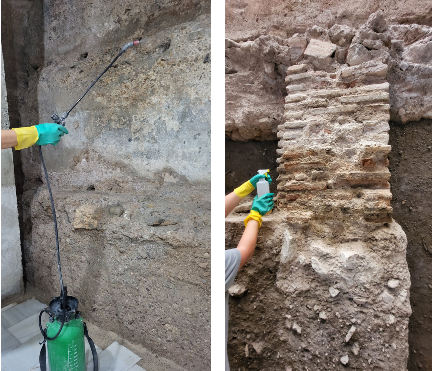
Figuras 24 y 25. Proceso de consolidación química. Fuente: Arqueonaturaleza SL.
