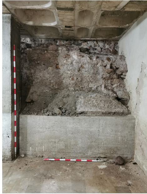
Figuras 4 y 5. Estado inicial del pilar colapsado antes de su intervención y de los desprendimientos de la antemuralla. Fuente: Arqueonaturaleza SL.
