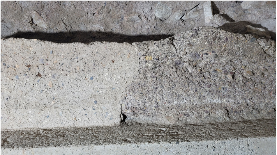
Figura 30. Reintegración volumétrica del calicastro de la antemuralla 1. Fuente: Arqueonaturaleza SL.
