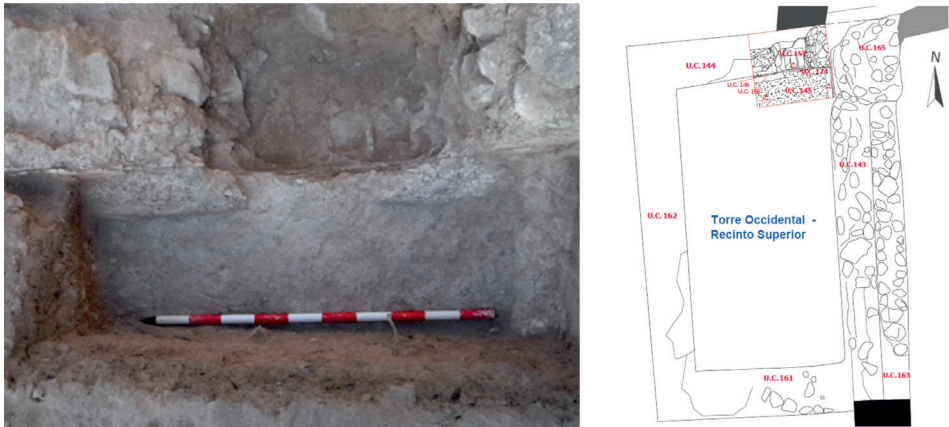
Figura 13.- Vista cenital de detalle del pavimento y media caña documentada durante la ejecución de una cata en el interior de la habitación y planimetría de la torre.
