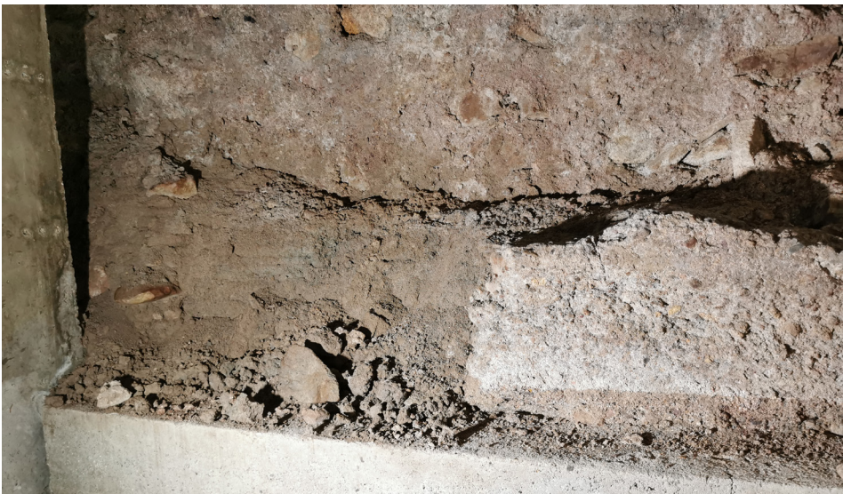
Figura 19. Detalle del estado de conservación previo de la antemuralla 1 con la pérdida puntual de costra calicestrada externa y desprendimiento de relleno limoso interior. Fuente: Arqueonaturaleza SL.
