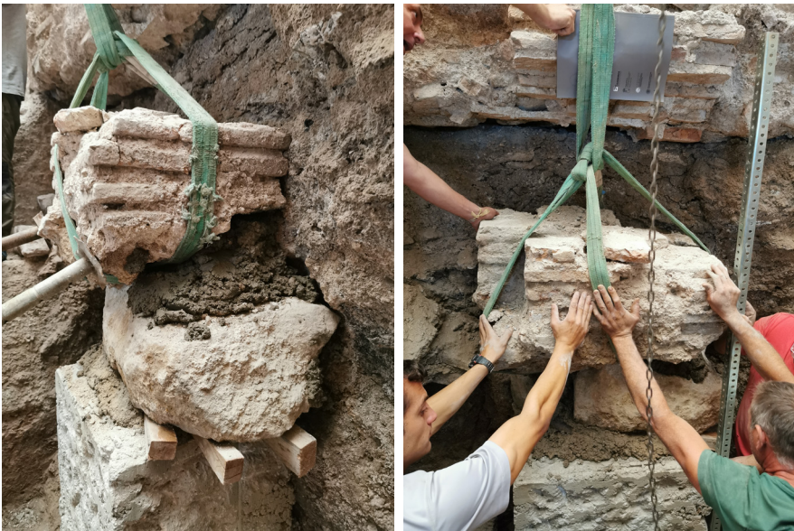
Figuras 9 y 10. Colocación de la parte inferior del pilar sobre la cimentación de mampostería. Fuente: Arqueonaturaleza SL.
