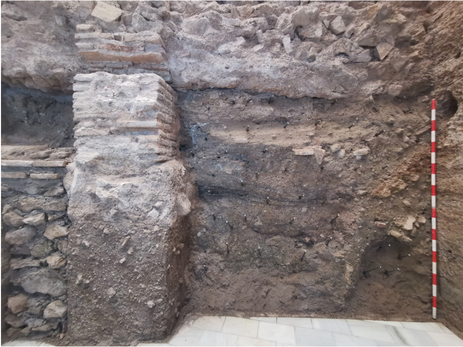
Figura 13. Proceso intermedio de las actuaciones realizadas en el pilar de ladrillos y el refuerzo del perfil estratigráfico de la barbacana. Fuente: Arqueonaturaleza SL.
