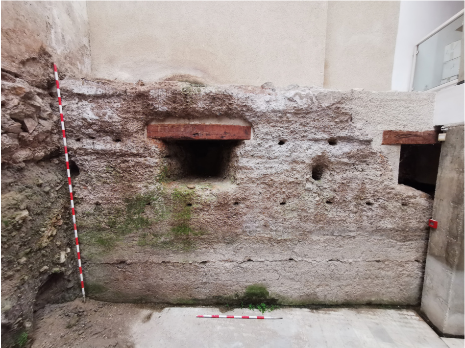
Figura 20. Vista general del estado de conservación previo de la antemuralla 2 (zona sur) con un importante desarrollo de microorganismos (líquenes y musgos), plantas, ataque de insectos xilófagos en las vigas de madera de las saeteras, etc. Fuente: Arqueonaturaleza SL.
