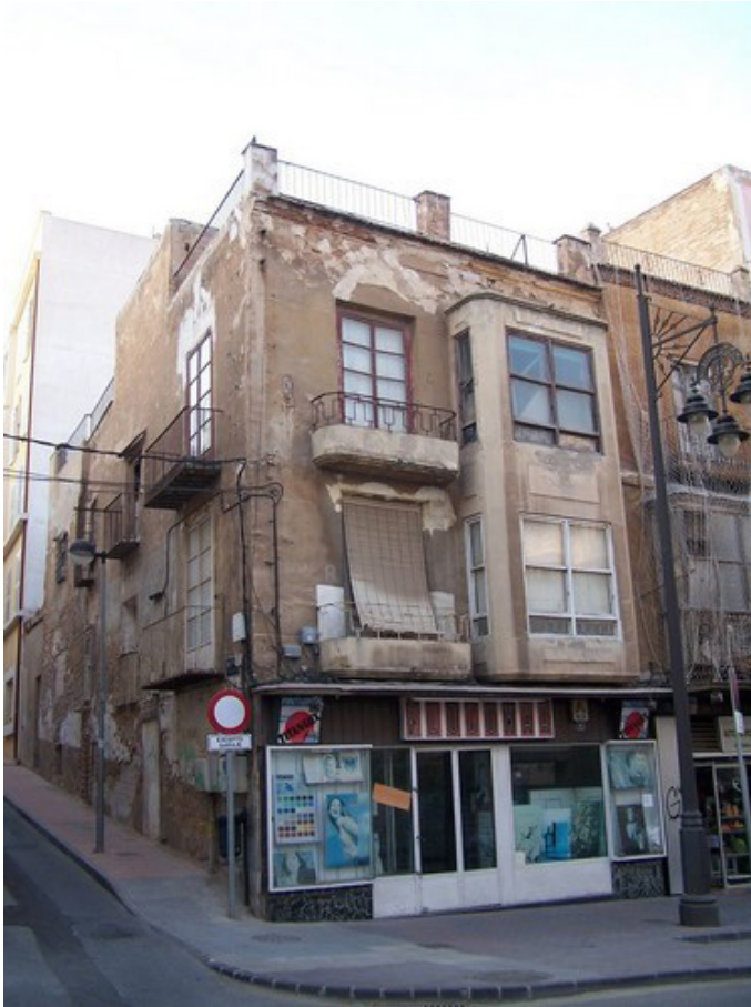
Figura 5. Fotografía recuperada del catastro virtual, antes de la demolición del edificio.
