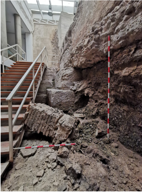
Figuras 4 y 5. Estado inicial del pilar colapsado antes de su intervención y de los desprendimientos de la antemuralla. Fuente: Arqueonaturaleza SL.
