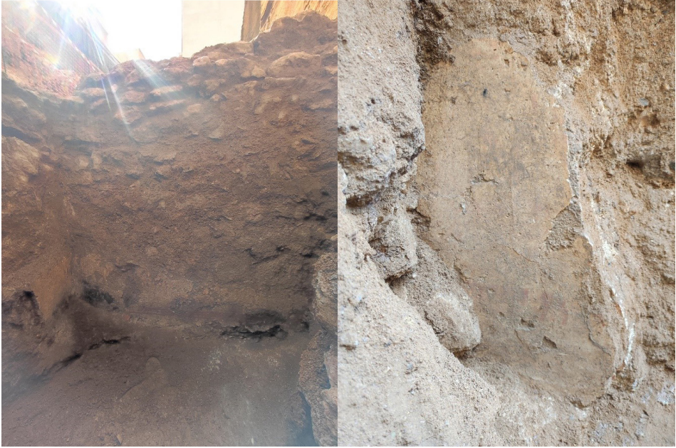
Figura 20. Unión de ambos muros con los revestimientos conservados. Esquina noroeste conservada dentro del pozo – detalle pintura.
