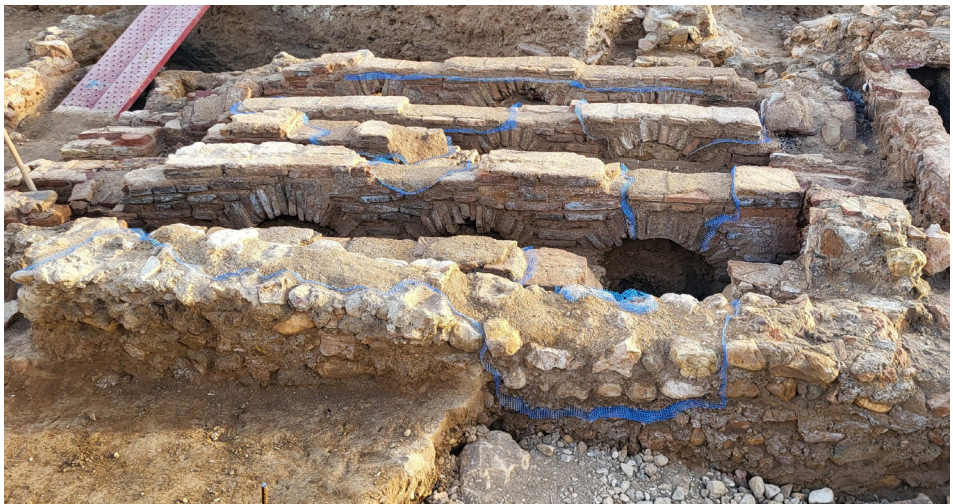
Figuras 9 y 10. Estado inicial y final tras la consolidación estructural de las arcadas centrales del sistema de hipocausto de las termas (Arqueonaturaleza SL)
