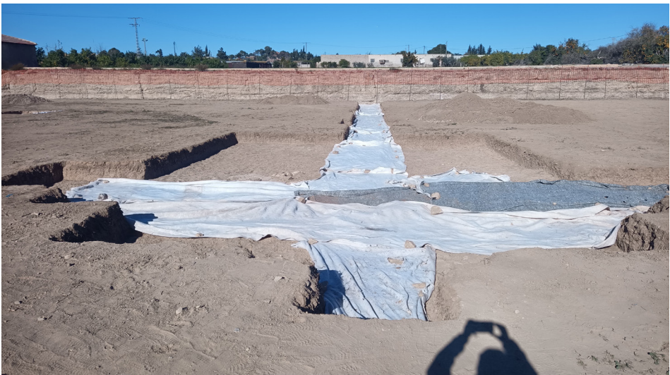
Figuras 23. Cubrición con geotextil y tierra de los restos y sondeos.
