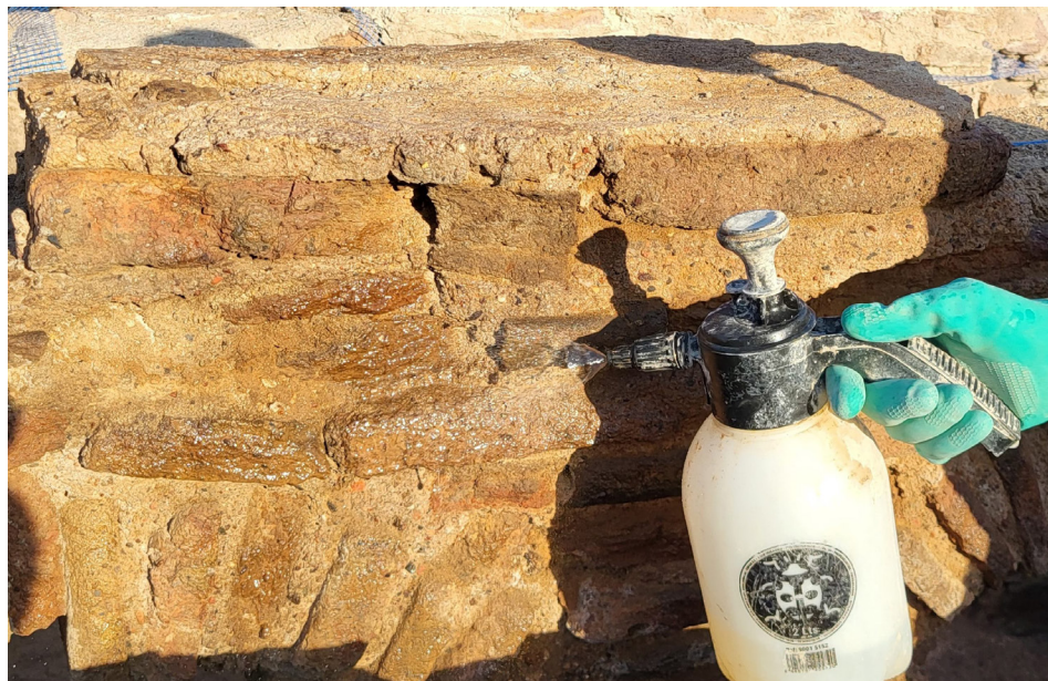
Figura 4. Proceso de consolidación química de las estructuras arqueológicas (Arqueonaturaleza SL)
