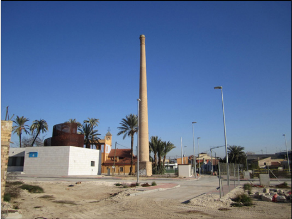
Figura 2. Vista general del elemento.
