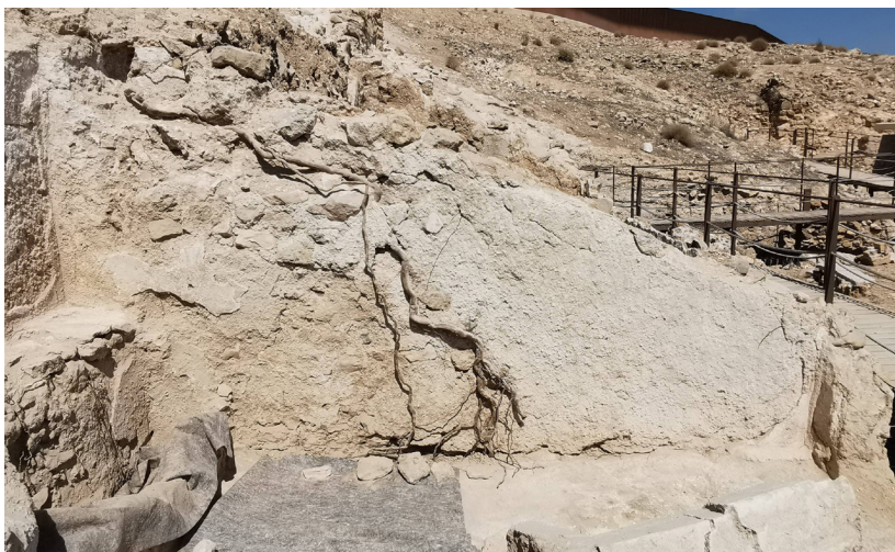
Figura 11. Proceso de limpieza de estructuras deterioradas debido a importantes enraizamientos vegetales que provocaban el levantamiento de los materiales constructivos. Una vez retirados, se realizó una limpieza superficial de forma más profunda para eliminar los depósitos de tierra existentes y la suciedad no concrecionada mediante métodos mecánicos con ayuda de brochas, cepillos, espátulas, palillos de madera, etc. (Fuente: Arqueonaturaleza)
