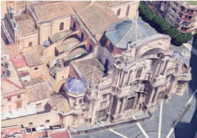
Figura 11. Bóveda restaurada en lateral de imafrente.
