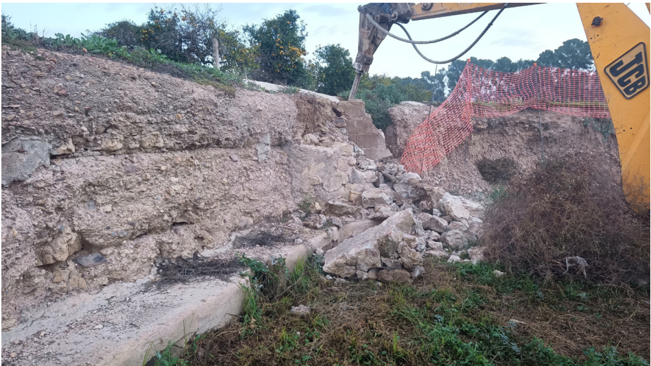
Figuras 16. Actuaciones de desbroce.
