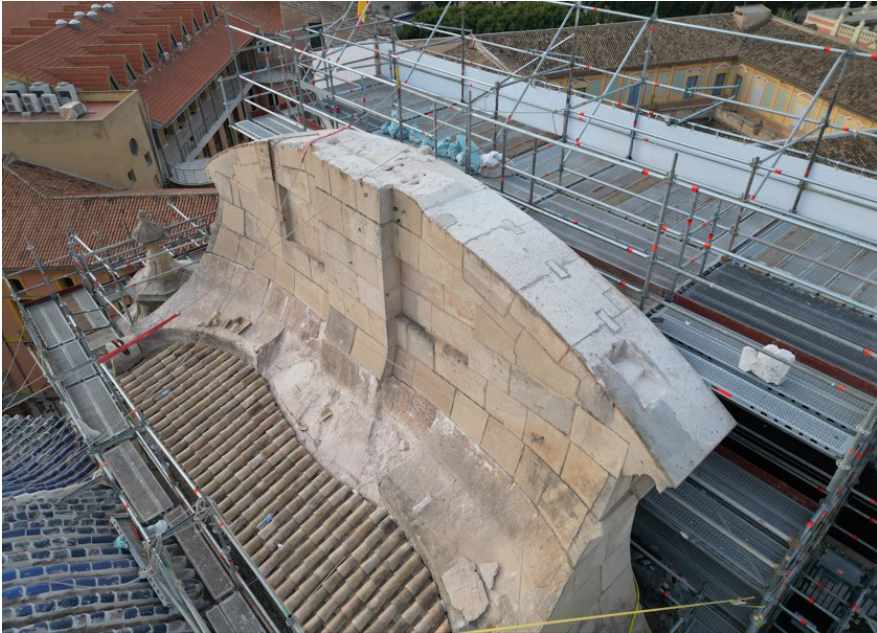
Figura 9. Parte superior del imafronte. Vista cenital tomada por un dron.
