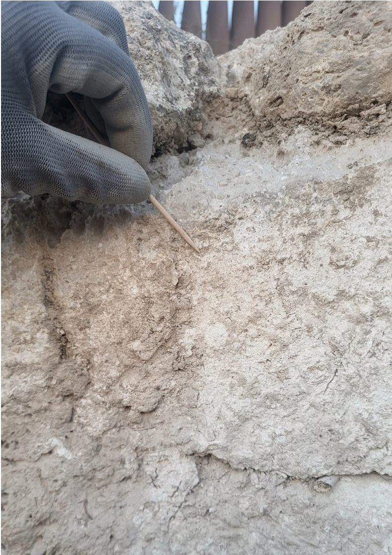
Figura 12. Proceso de limpieza de estructuras deterioradas debido a importantes enraizamientos vegetales que provocaban el levantamiento de los materiales constructivos. Una vez retirados, se realizó una limpieza superficial de forma más profunda para eliminar los depósitos de tierra existentes y la suciedad no concrecionada mediante métodos mecánicos con ayuda de brochas, cepillos, espátulas, palillos de madera, etc. (Fuente: Arqueonaturaleza)
