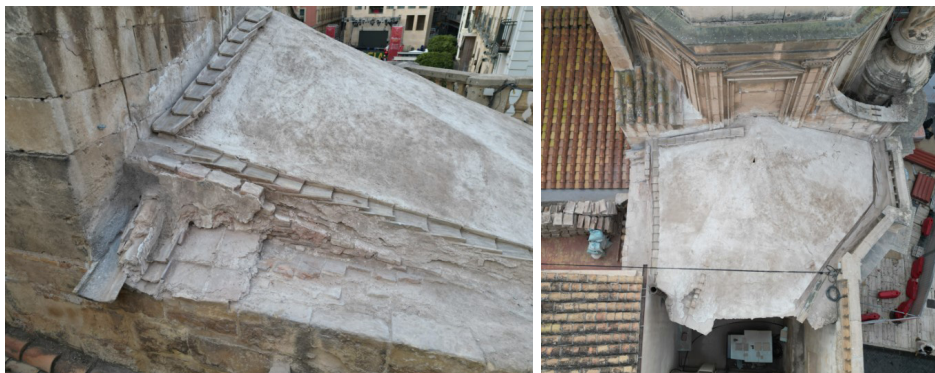
Figura 13. Vista cenital de la cúpula.
