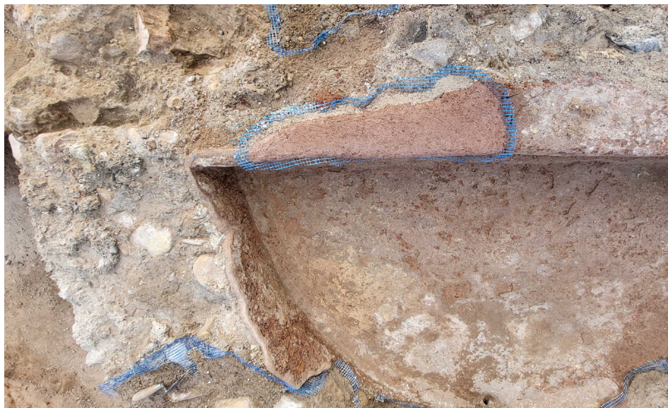
Figura 8. Reintegración de una laguna en el revestimiento de opus signinum de la pileta semicircular (Arqueonaturaleza SL)
